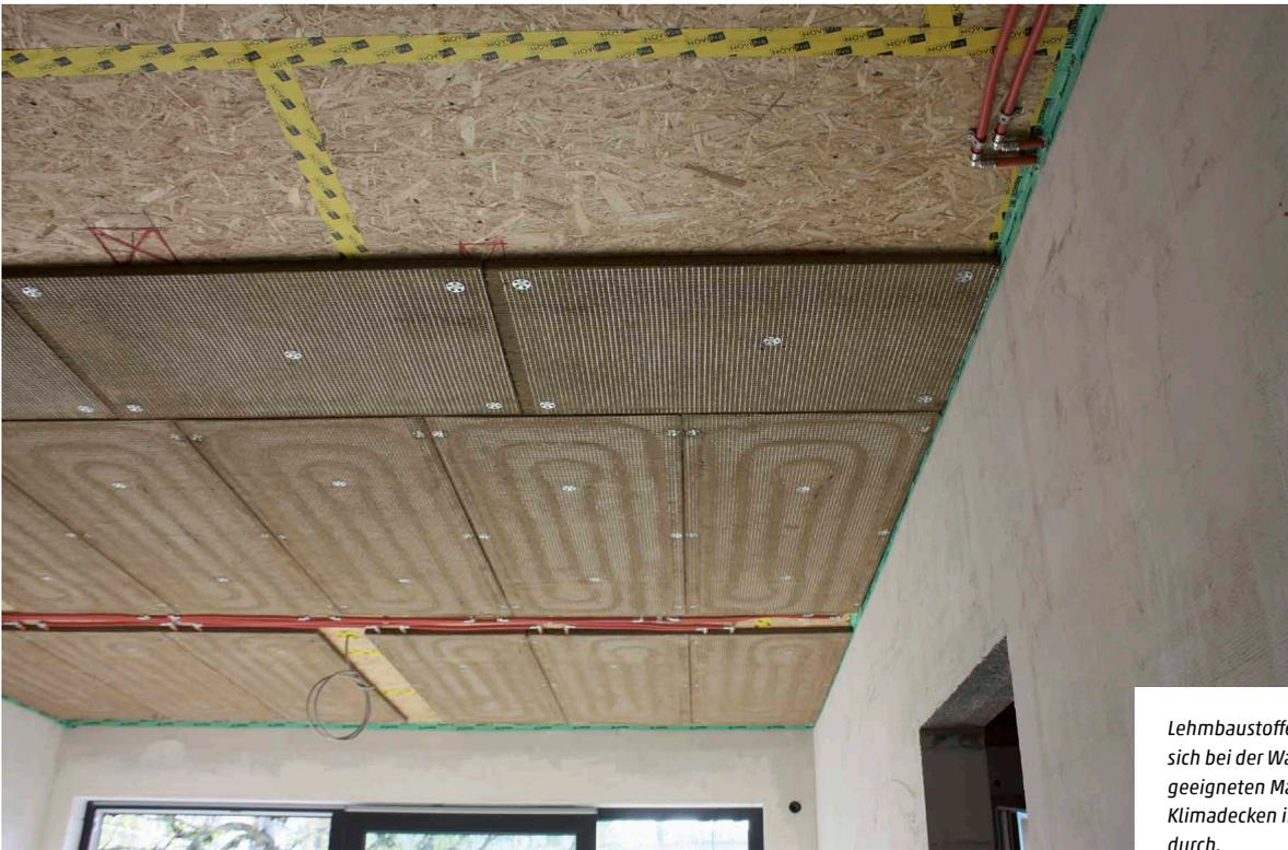
*Lehmstoffe setzen sich bei der Wahl eines geeigneten Materials für Klimadecken immer mehr durch.*
