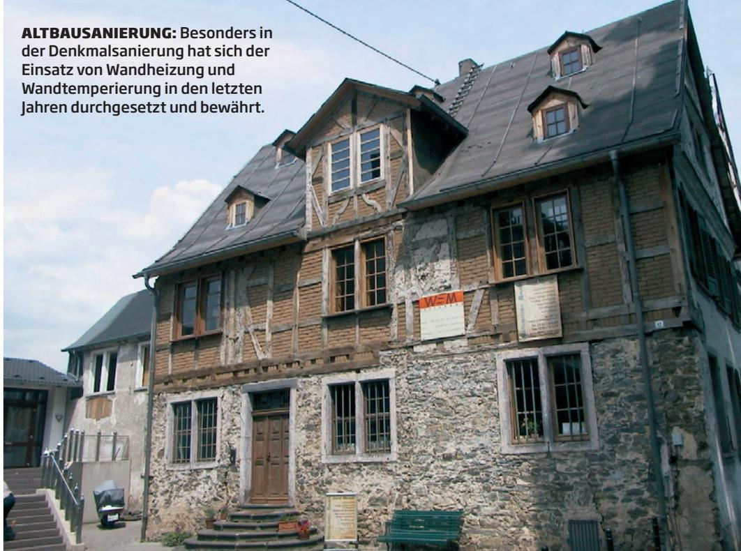
**DIE GLEICHMÄSSIGE** Erwärmung der Wände wirkt bauteilkonservierend. Oft werden Wandheizungssysteme als thermische Horizontalsperre eingesetzt.
