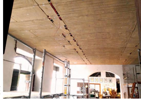
Geringe Aufbauhöhen und raumklimatisch vorteilhaft: Das sind die Stärken einer Klimadecke mit Lehmmörtel.
