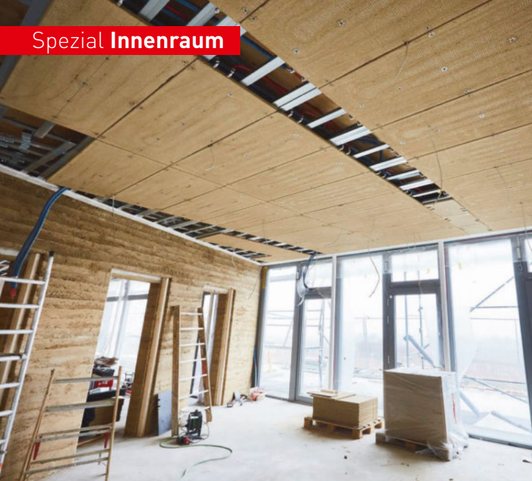
Die Lehmelemente mit den wasserführenden Rohren wurden hier an eine Metallunterkonstruktion unter der Brettstapeldecke verschraubt. Die Anschlussbereiche der Rohre werden noch mit Lehmplatten abgedeckt.
