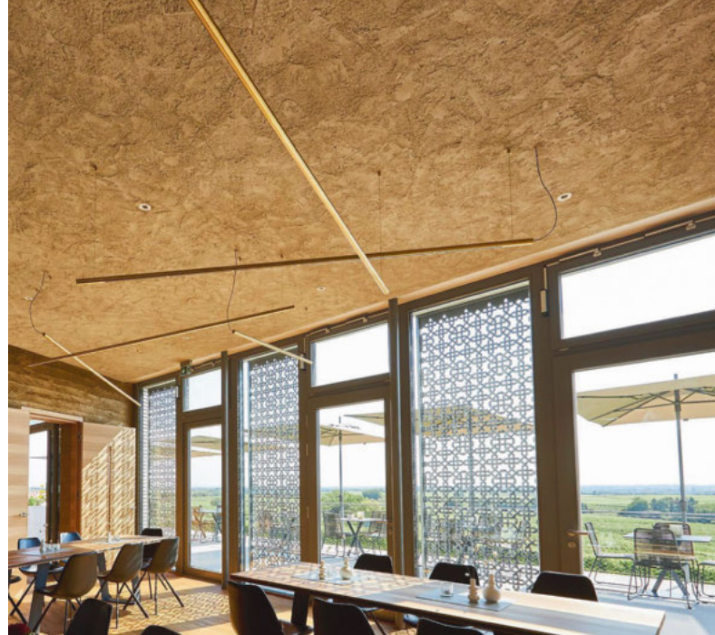
In den großzügigen Räumen verteilt sich die Wärme (oder Kühle im Sommer) aufgrund der permanenten Reflexionen der Strahlung von der Decke sehr gleichmäßig.
