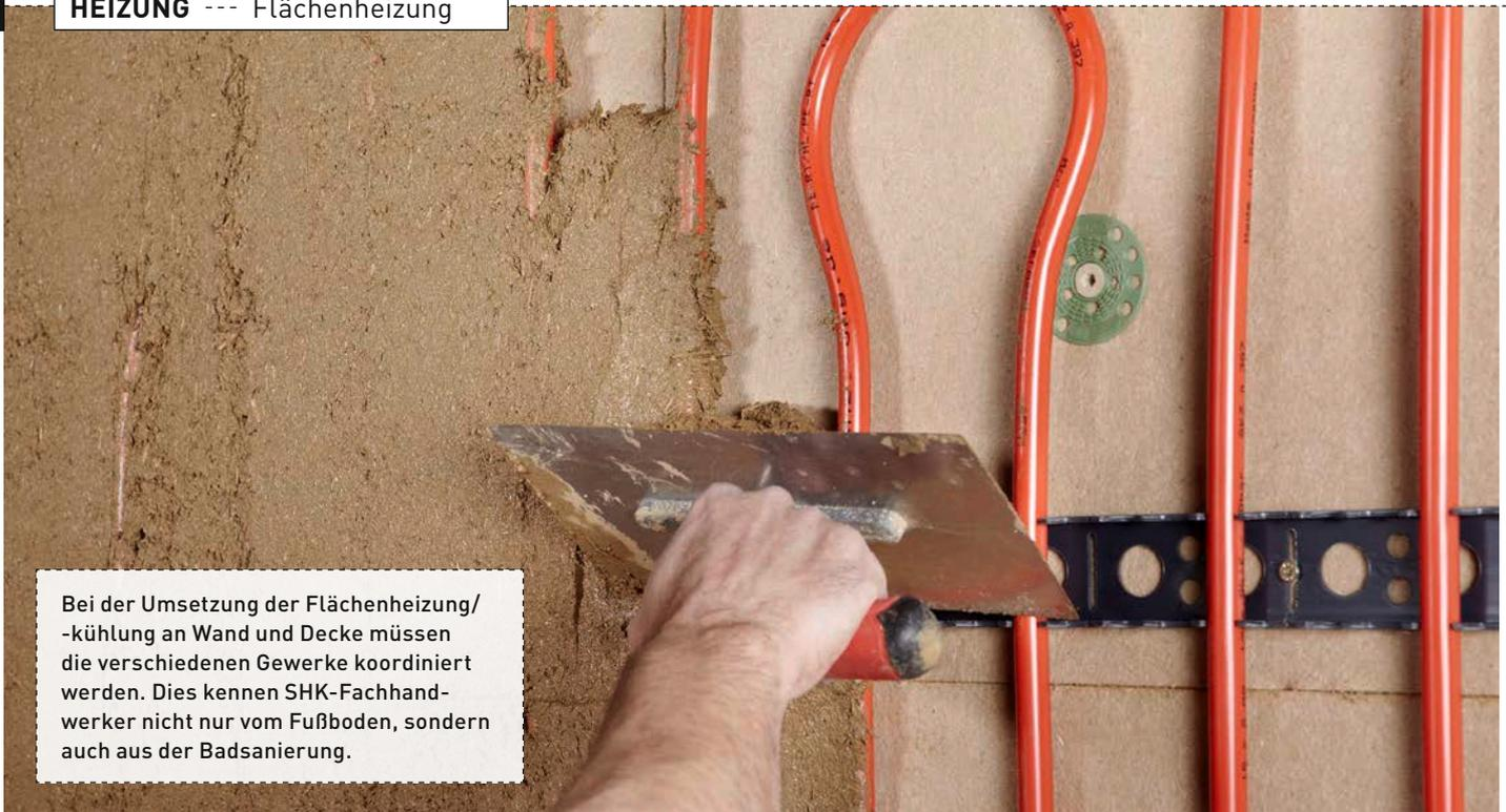
Bei der Umsetzung der Flächenheizung/-kühlung an Wand und Decke müssen die verschiedenen Gewerke koordiniert werden. Dies kennen SHK-Fachhandwerker nicht nur vom Fußboden, sondern auch aus der Badsanierung.
