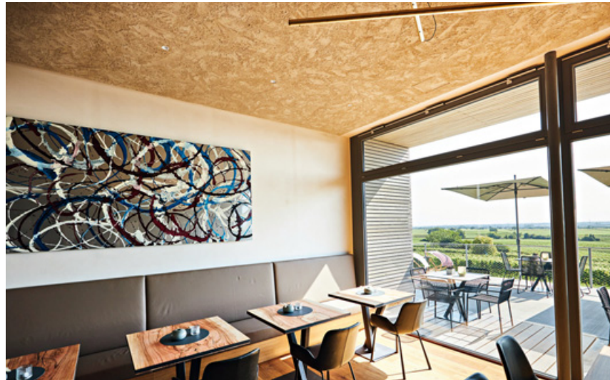
Unsichtbar in die Decke eingebaut sorgen die Klimatelemente für bestes Raumklima mit angenehmer Strahlungswärme oder Kühlung.
