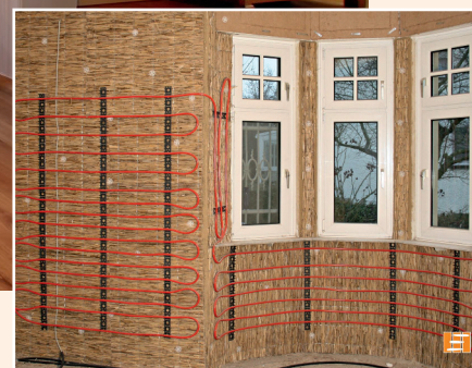
1 + 2 Bei dieser Villa wurde wegen der höheren Flexibilität das WEM Klimarohrsystem gewählt. Der Stuckateur verlegte die Rohrleitungen auf der Schilfrohrdämmung und verputzte sie mit Lehmputz.
