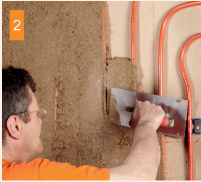
3 Die Rohrregister werden mit Schrauben oder Dübeln befestigt und mit Pressfittings verbunden. Danach werden die Wandheizungsrohre mit Kalk oder mit Lehm verputzt.
