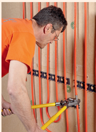
5 Vor dem Verputzen wird eine Druckprüfung durchgeführt, die sicherstellt, dass das System dicht ist.
