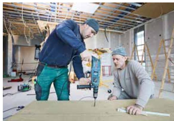
Die Platten werden mit Schrauben befestigt. Bei der Deckenmontage wird das Klimatelement, das auch als Wandheizung eingesetzt werden kann, mit zusätzlichen Befestigungspunkten gesichert
