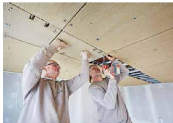
**Die zugeschnittenen Lehmplatten werden eingepasst. Es entsteht eine durchgehende Fläche, die anschließend mit Lehm verputzt wird**
