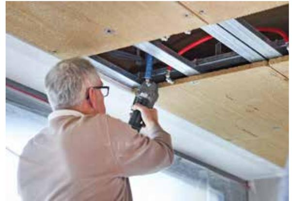
Rechts: Maximal fünf Klimaelemente werden in Reihe geschaltet und an den Heizkreisverteiler angeschlossen (blau isolierte Leitung)
