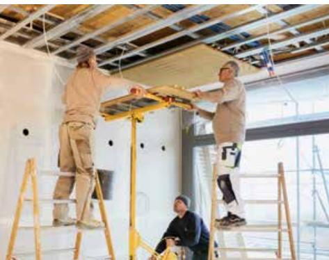
◀ Die Lehmplatten mit den integrierten wasserführenden Rohren werden mit einem Plattenheber an die Decke gehoben ...
