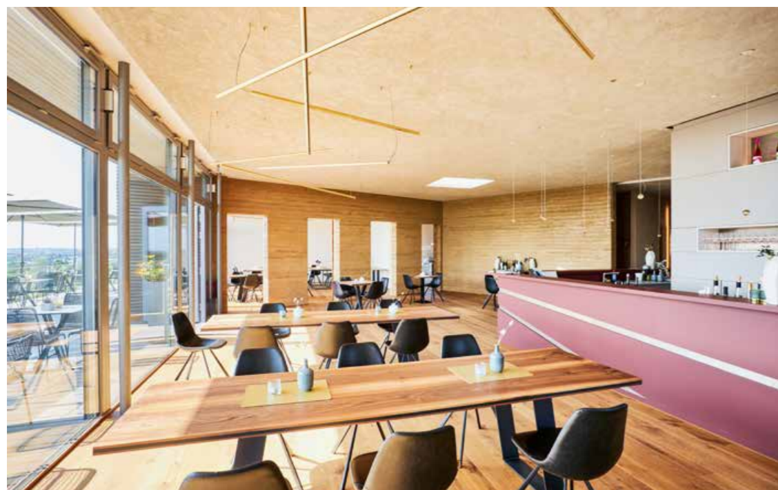
◀ In den großzügigen Räumen verteilt sich die Wärme (oder Kühle im Sommer) aufgrund der permanenten Reflexionen der Strahlung von der Decke sehr gleichmäßig
