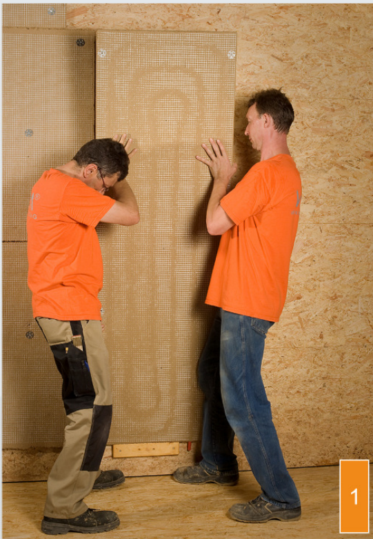
(1) Die Klimaelemente werden aufgestellt ...
