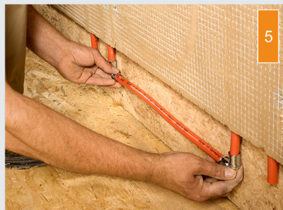
(5) Die wasserführenden Klimaelemente werden untereinander mit Rohrleitung verbunden ... (weiter auf Seite 10)
