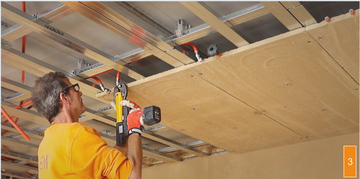
(3) Die Klimaelemente werden miteinander verbunden.
