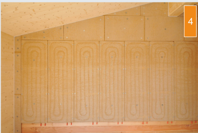
(5) Die wasserführenden Klimaelemente werden untereinander mit Rohrleitung verbunden ... (weiter auf Seite 10)
