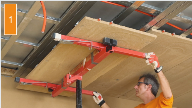
(1) und (2) Die Klimaelemente werden mit einem Plattenheber an die Decke gehoben und festgeschraubt.
