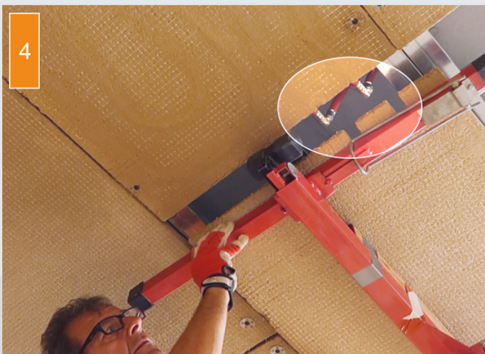
(3) Die Klimaelemente werden miteinander verbunden.
