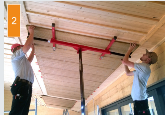
(1) und (2) Die Klimaelemente werden mit einem Plattenheber an die Decke gehoben und festgeschraubt.
