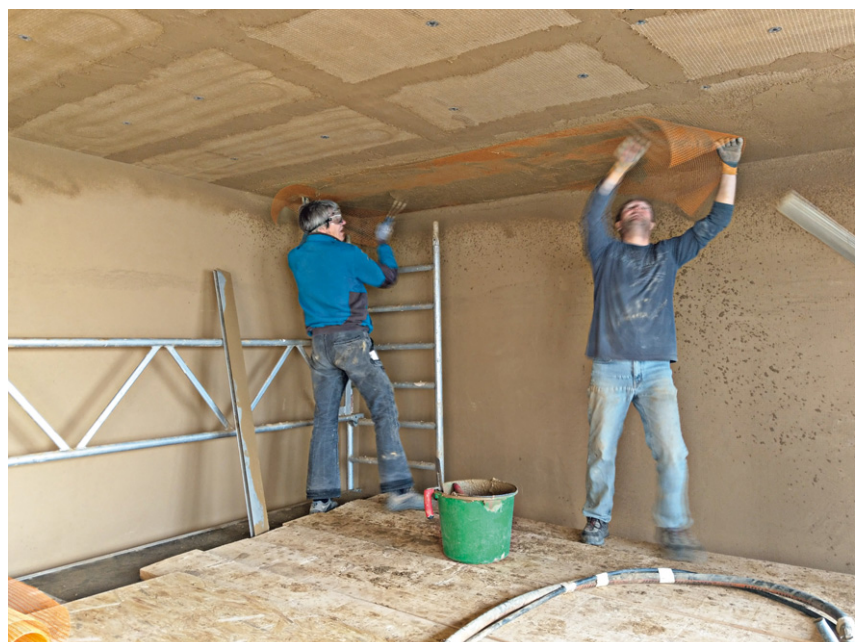
4 Verputzen der Klimadecke mit Lehmputz und Einbringen des Armierungsgewebes. Fotos: WEM
