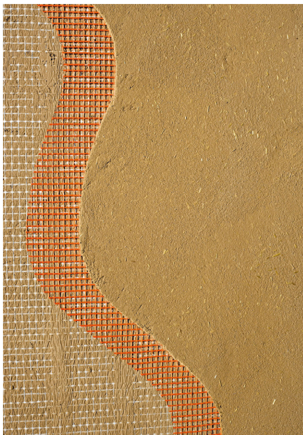
1 Der Schichtaufbau: Klimatelement mit Armierungsgewebe und anschließend Lehmputz.
