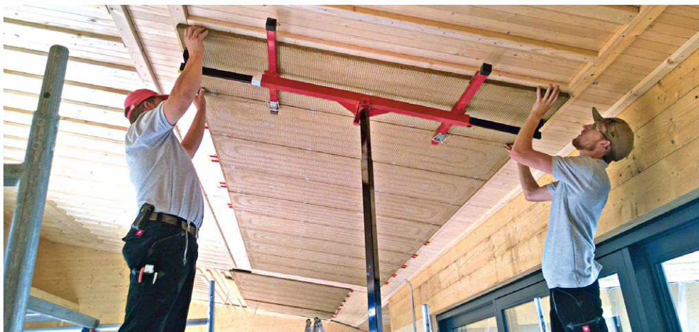
2 Die Klimadecke mit einer Aufbauhöhe von zirka 35 mm lässt sich auch in Altbauten nachrüsten.
