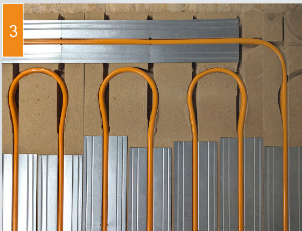
(3) Das Rohr wird verlegt.
