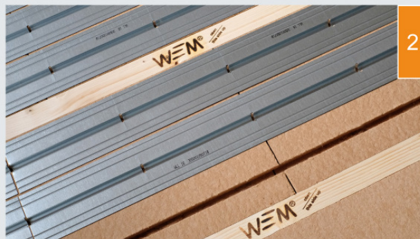
(2) Wärmeleitbleche werden in die Verlegeplatten eingelegt.
