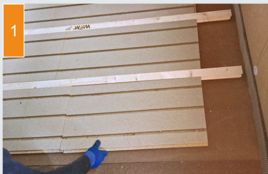
(1) Die Holzfaser-Verlegeplatten und Profileleisten werden ausgelegt.
