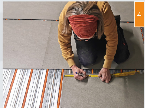
(4) Die Ceralanplatten werden verlegt.
