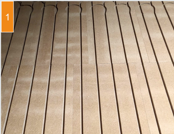
(1) Die Holzfaser-Verlegeplatten werden ausgelegt.
