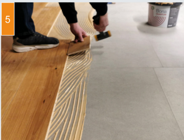
(5) Das Parkett wird auf dem Ceralan-Belag verklebt.
