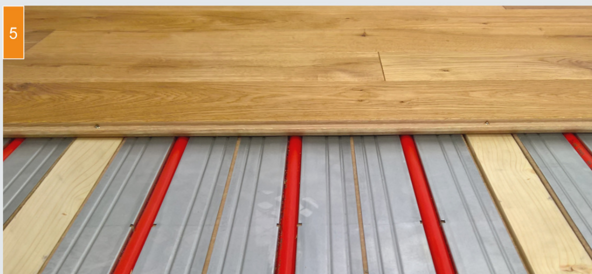
(5) Der Bodenbelag wird verlegt (in diesem Beispiel Eichendielenboden).
